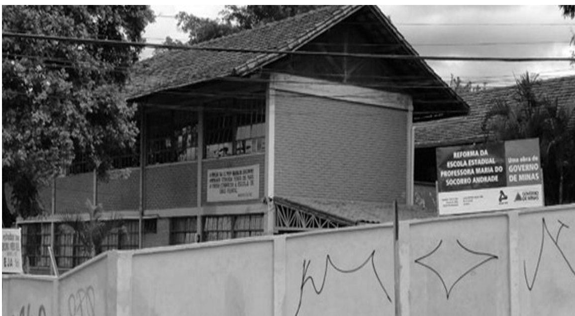
Fachada da escola Estadual Maria do Socorro em Belo Horizonte, (MG). Foto: Douglas Magno, Super Notícia. 17/08/2012.
